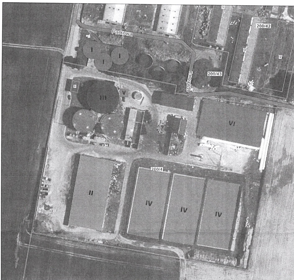
Rysunek 1 Miejsca magazynowania odpadów przewidzianych do przetworzenia w biogazowni Skarżyn oraz powstających w wyniku przetwarzania
